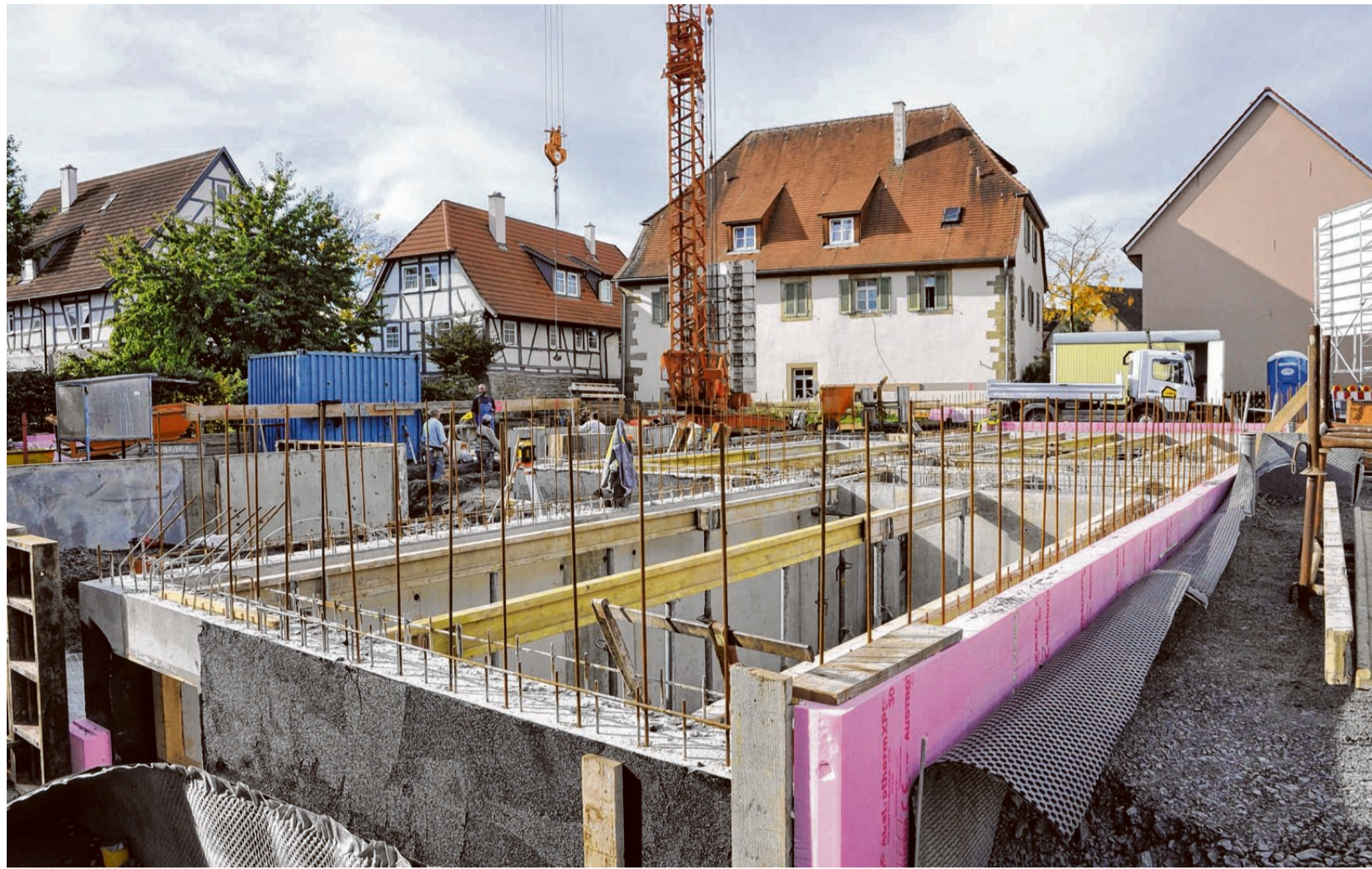
Rund 1,2 Millionen Euro investiert die Baugenossenschaft Familienheim in ein Mehrfamilienhaus, das gerade im Eppinger Gänsgartenweg gebaut wird.
